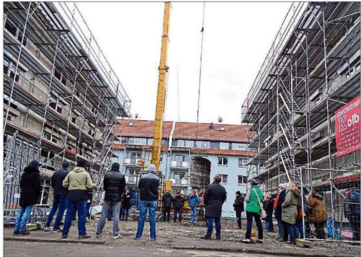
Richtfest in der Fuldastraße: Bis Jahresende sollen die 24 Wohnungen in den beiden Neubauten bezugsfertig sein. (Foto: mö)
