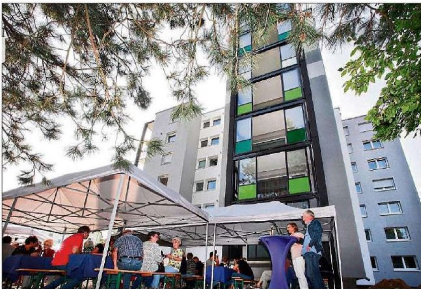
Die Bauarbeiten am Haus Reichelsberg 7 neigen sich dem Ende zu. Das wird hier mit einem Fest gefeiert (Foto: ep)
