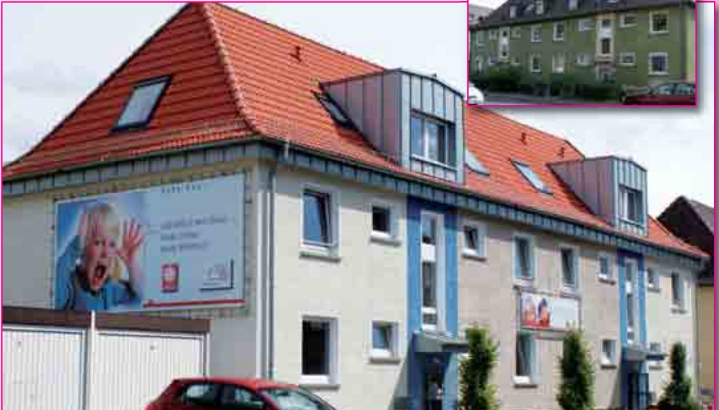
Premiere für die Wohnbau: Aus dem stark sanierungsbedürftigen Wohnhaus in der Schottstraße wurde eine Kindertagesstätte mit Familienzentrum
